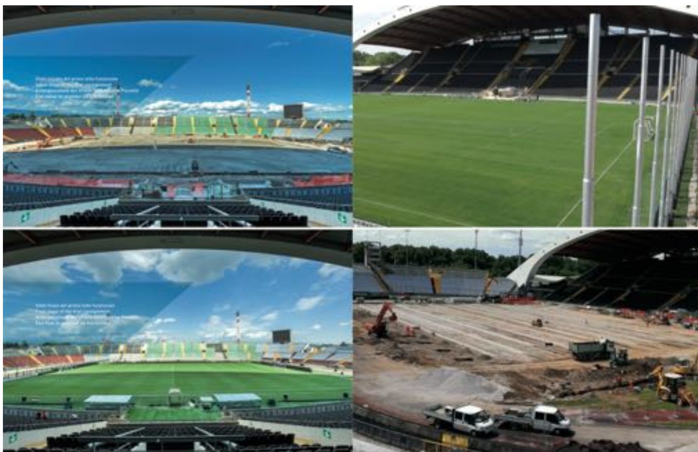
STADIO FRIULI - Comune di Udine. Rifacimento e spostamento campo di gioco, nuove panchine giocatori e quarto uomo, recinzione di cantiere, installazione seggiolini tribuna ovest.
